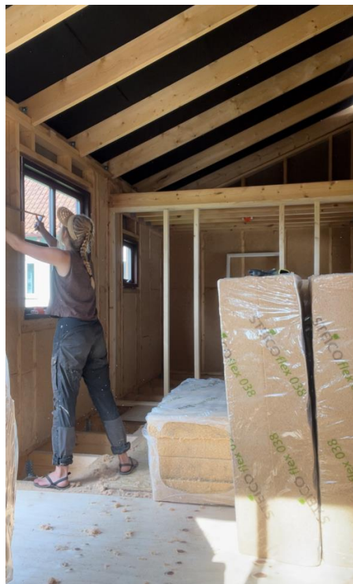
Jeg måler, skærer og isolerer på livet løs med velduftende træfiberbats.
