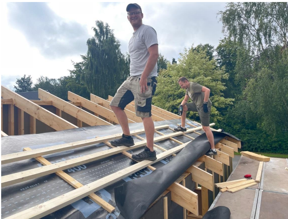
Tømrer-Jon og Fader-Jens hjælper mig med at lægge undertag, inden vintervejret kommer.
