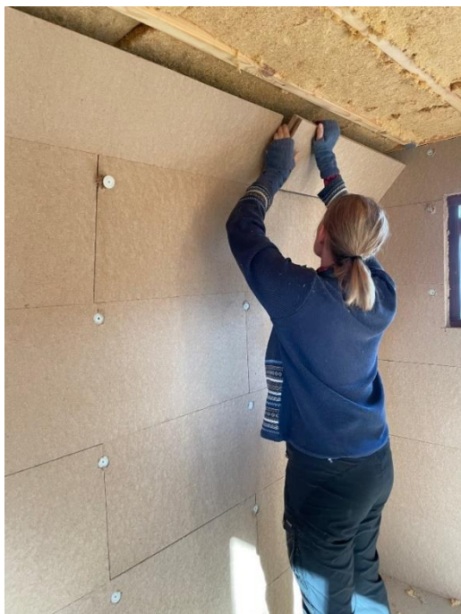
Med endnu en ven sætter jeg de indvendige, pudsbare træfiberplader op.
