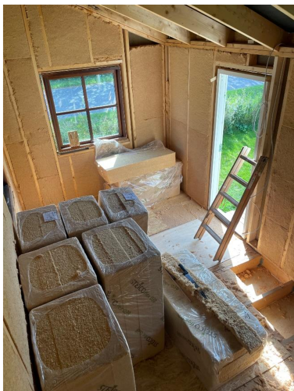
Jeg måler, skærer og isolerer på livet løs med velduftende træfiberbats.
